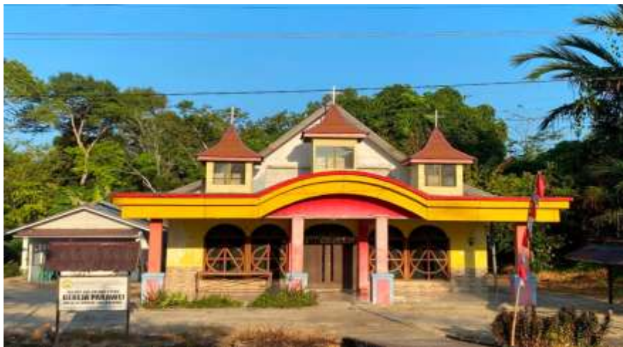
Gambar 4.1 Bangunan Gedung Gereja Parawei Kalawa
