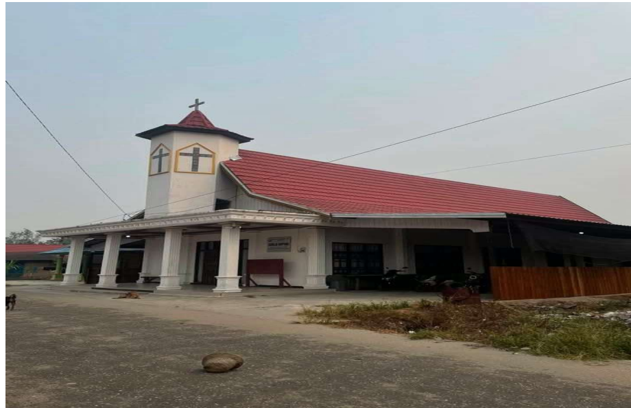
Gambar 4.1 Bangunan Gereja GKE Ampung Kampuri
